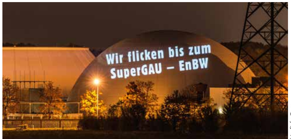
.ausgestrahlt warnte schon 2018, dass bloßes Verstopfen der rissigen Rohre die Gefahr nicht beseitigt
