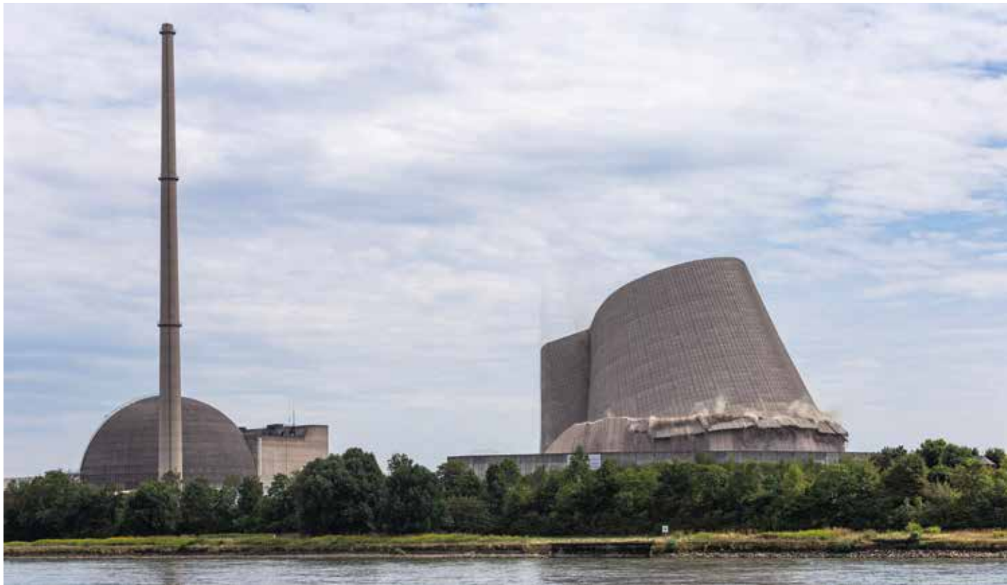
Abriss des Kühlturms des AKW Mülheim-Kärlich bei Koblenz am 9. August
