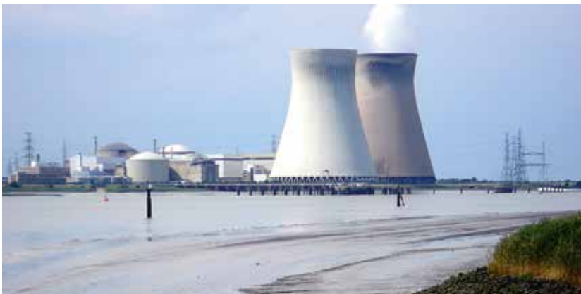
Ohne gültige Betriebsgenehmigung: AKW Doel, Belgien
