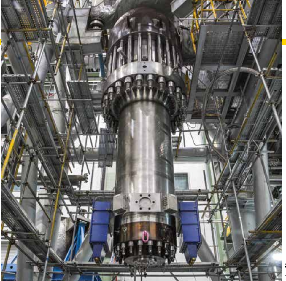
Hauptkühlmittelpumpe aus Frankenthal für chinesisches AKW
