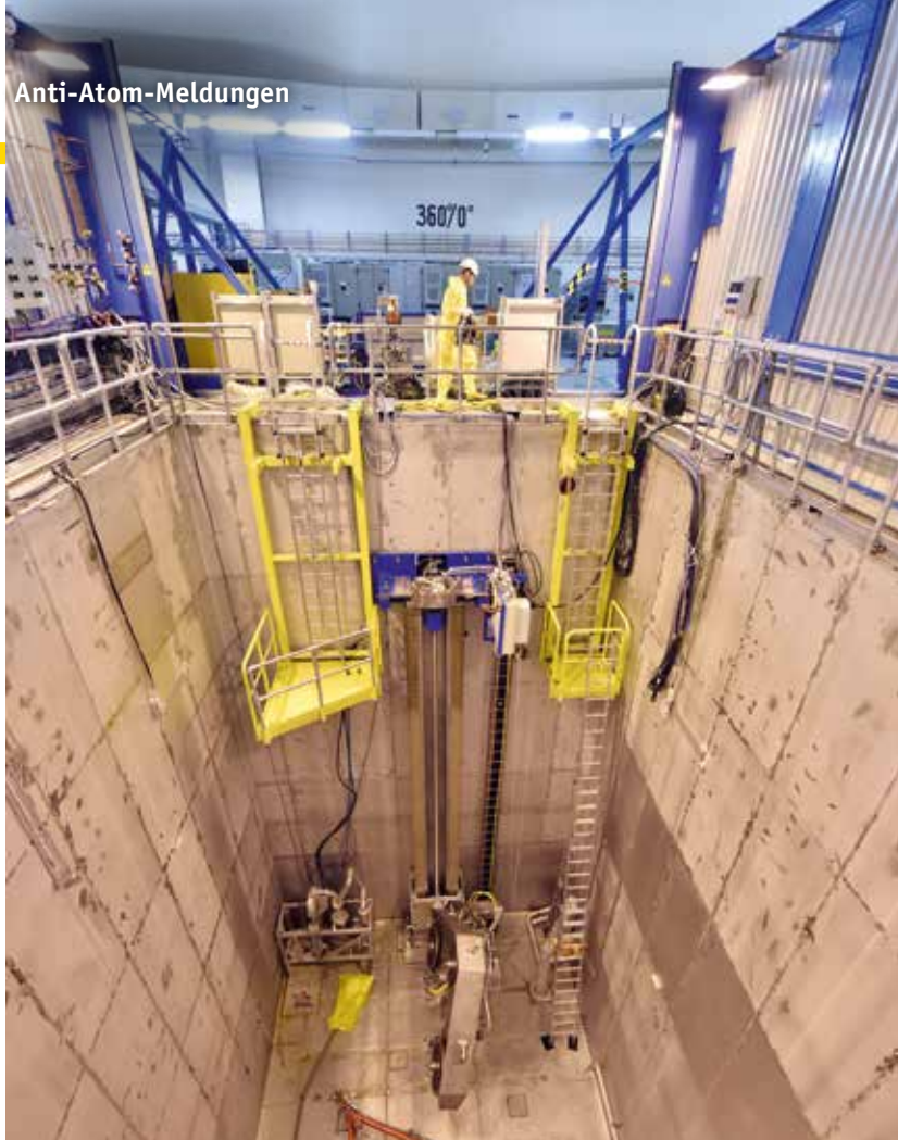
Im ehemaligen Brennelemente-Lagerbecken des AKW Obrigheim wurde auch der kontaminierte Reaktor-druckbehälter unter Wasser zersägt.
