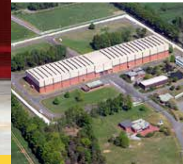
Zwischenlager-Halle in Ahaus
