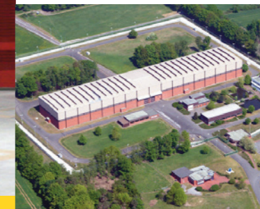
Zwischenlager-Halle in Ahaus
