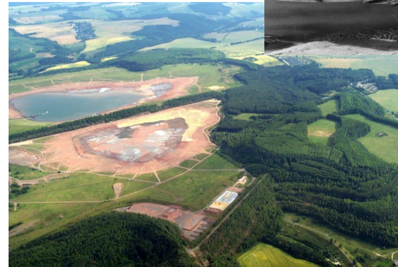
Absetzanlage Culmitzsch, Quelle: mapio.net Kontaminierter Schrott in Kassetten mit Beton vergossen; kontaminierter Bauschutt oberhalb der Freimesswerte.
