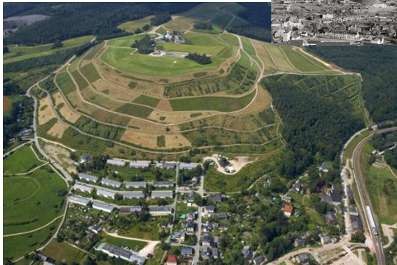
Bad Schlema, Sachsen, Quelle: BMWI Radioaktiver Schrott und kontaminierter Bauschutt oberhalb der Freimesswerte.
