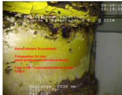
Ansicht oberes Fassdrittel mittels Inspektionskamera
