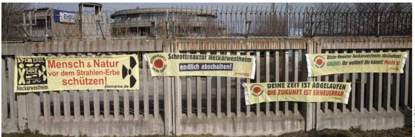
Im AKW Neckarwestheim korrodiert nicht nur der Zaun
