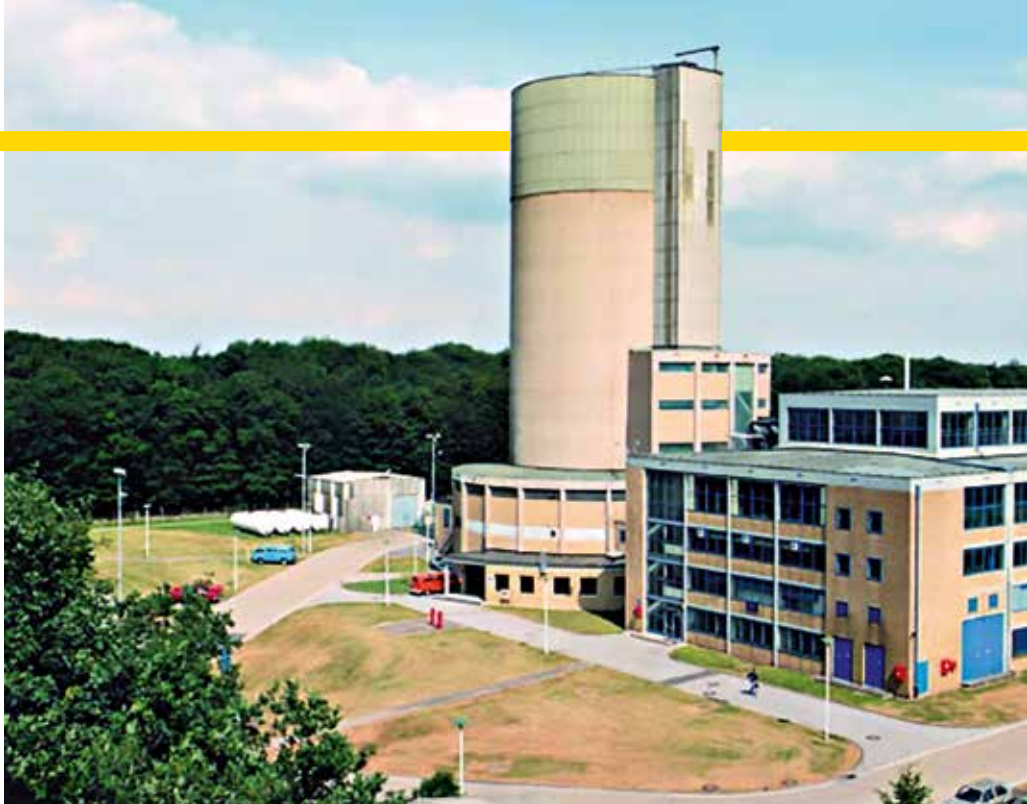
Mini-Reaktor, Baujahr 1961: Der AVR Jülich in Nordrhein-Westfalen lieferte 15 Megawatt Strom. Siemens versuchte in den 1980ern, ein 200-Megawatt-Modul desselben Typs zu vermarkten, scheiterte aber, weil nicht mal der AVR richtig lief. Ein Whistleblower enthüllte im Nachhinein schwere Störfälle und Sicherheitsdefizite. Der Zustand des AVR zu Betriebsende entsprach dem eines havarierten Reaktors mit Kernschaden.
